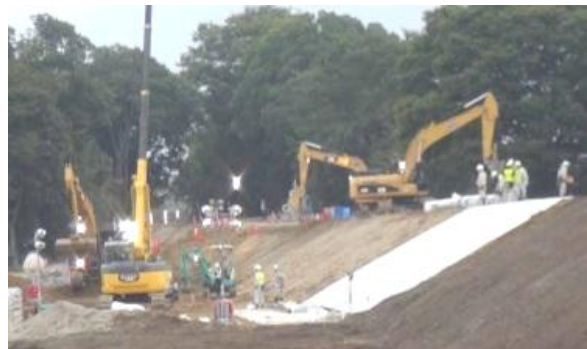
▲ 関東・東北豪雨応急復旧工事
