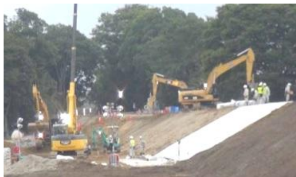
▲ 関東・東北豪雨応急復旧工事
